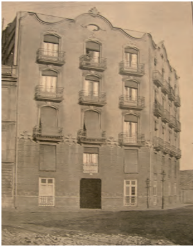
Fig. 6.- Edificio del mismo autor, demolido en los años ochenta, en la esquina de Gregorio Mayans con la Avda. del Regne, reproducido en la revista Arquitectura y Construcción , nº9/1912.
