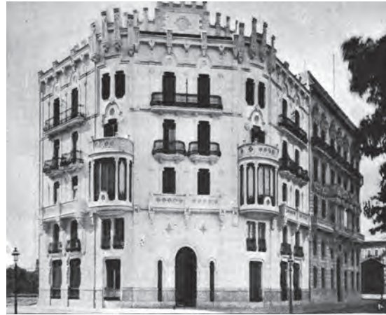
Fig. 12.- Edificio desaparecido de Jose M a Manuel Cortina en la Gran Vía Marqués del Turia, esquina a Gregorio Mayans. Revista Arquitectura y Construcción .
